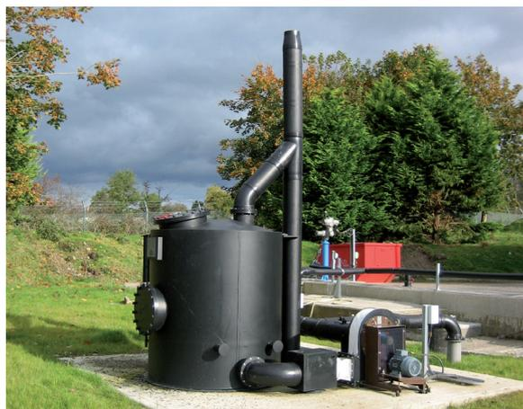
**L'adsorption sur charbon actif** : recommandées pour des installations de faibles débits et de faibles charges polluantes, les solutions **AyraCarb™** offrent une fiabilité et un rendement élevé.
